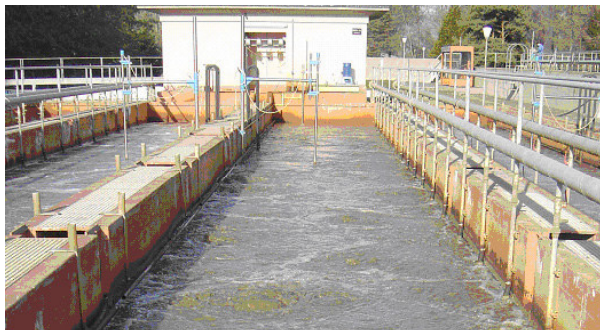
Vue sur les bassins en activité
