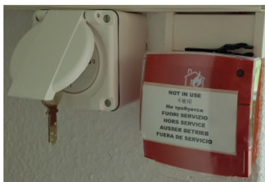
Fig. 1 : Interrupteur de coupure d'urgence pour pompiers
